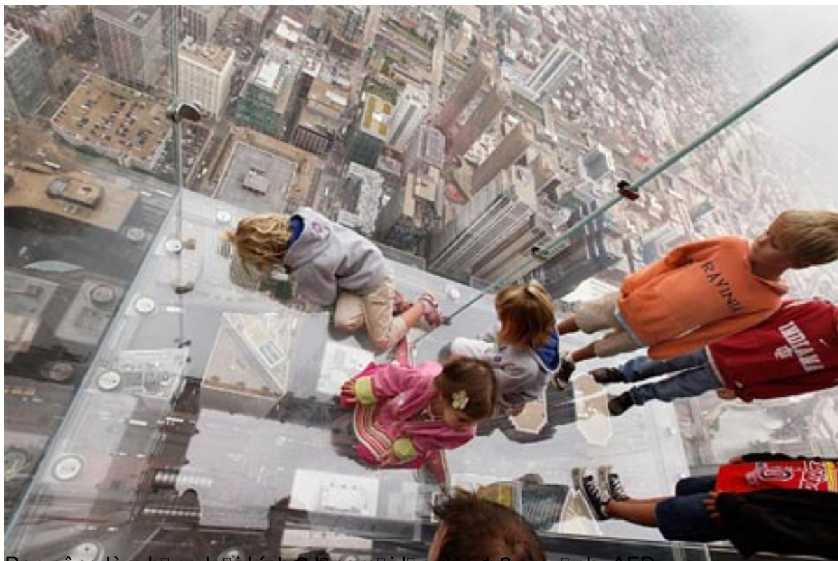
Ban công làm bằng kính 3 mm dày, nhìn xuống 130m. Ảnh: AFP
