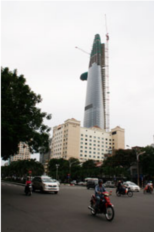
□ Công trình xây dựng Tòa nhà Bitexco Financial tại TPHCM. RFA PHOTO.
